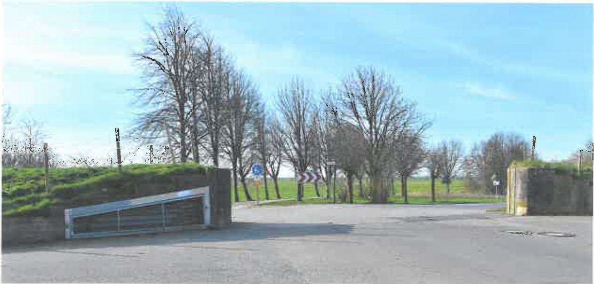
*Stöpe in Hetlingen mit seitlicher Lagerung der Dammbalken in einer Nische*
