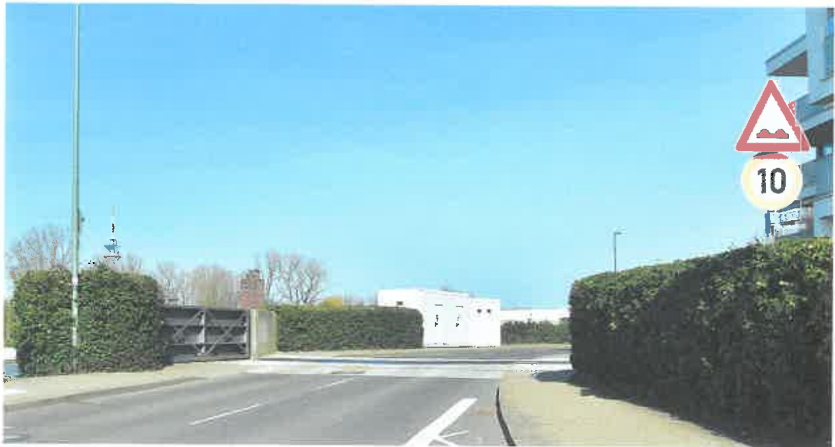
Stöpe Schulau am Hafen mit Stahltor
