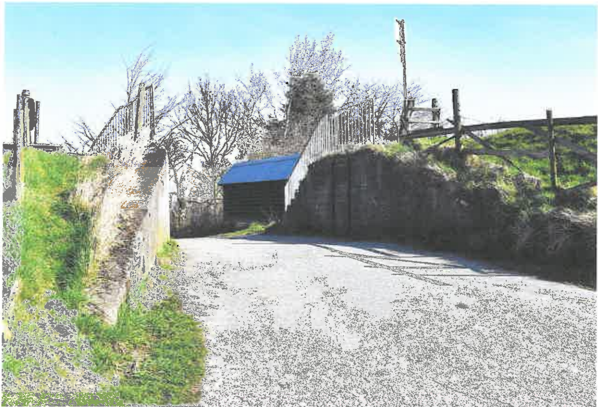
Stöpe und Stöpenhäuschen Esch, Straße zum Dockhafen am Pinnausperwerk
