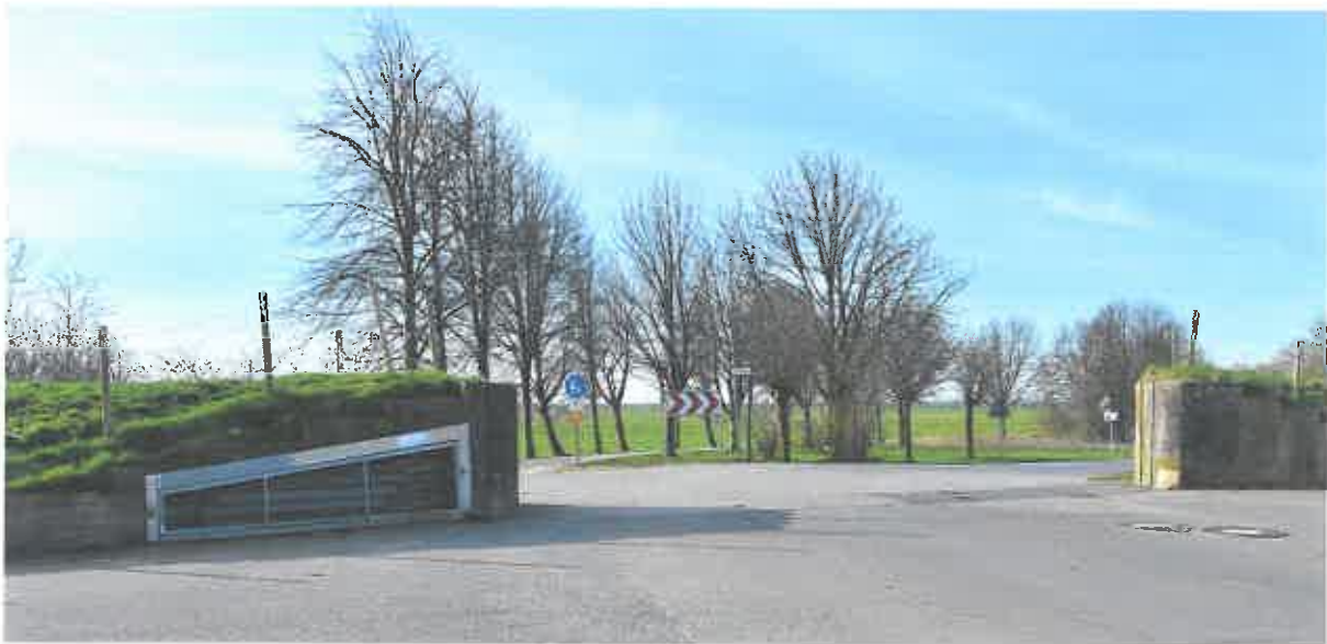
Stöpe in Hetlingen mit seitlicher Lagerung der Dammbalken in einer Nische
