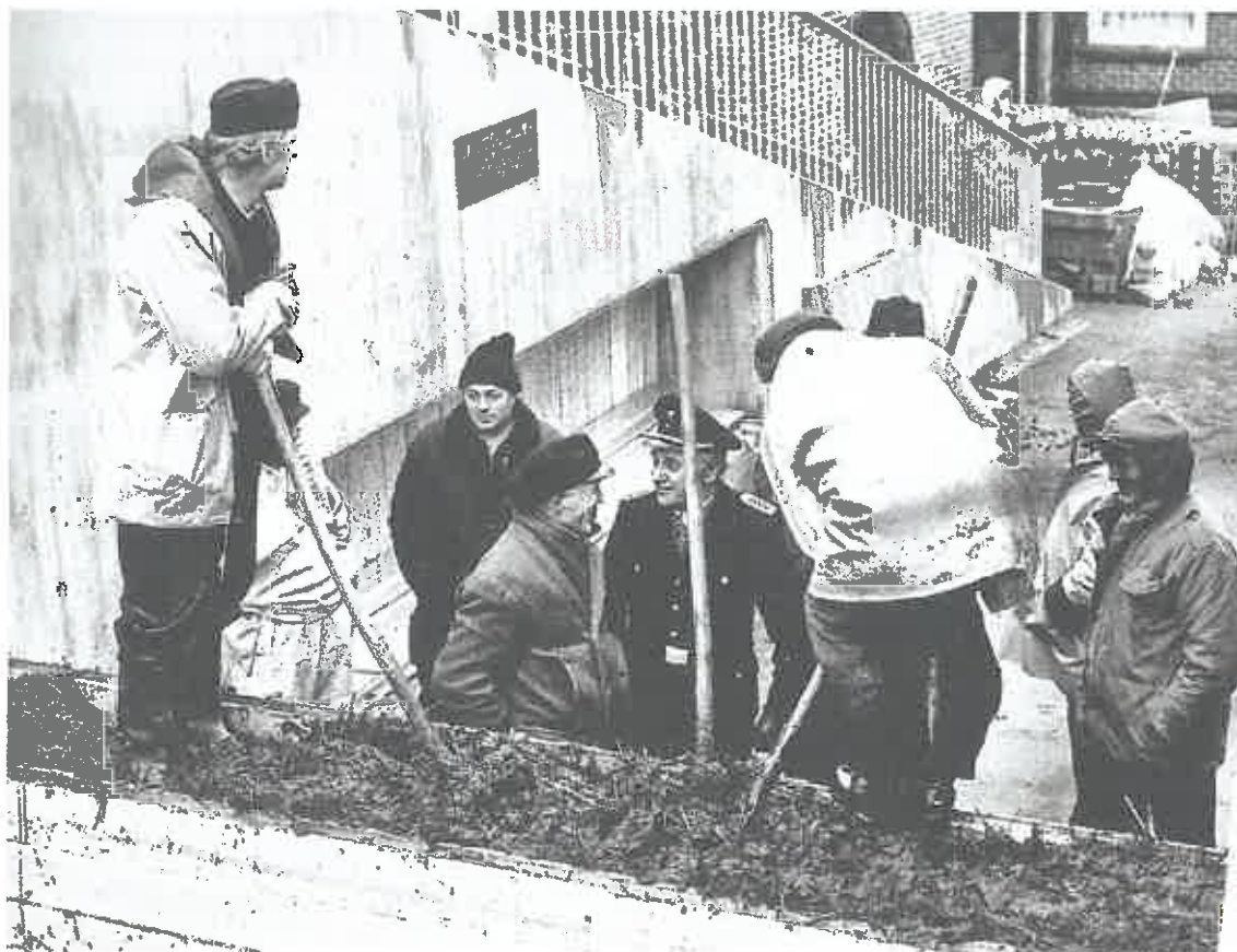
Die Stöpe ist mit Aluminiumdammbalken geschlossen und wird mit Kuhdung aufgefüllt. In der Betonwand ist die Nische zur Aufnahme der Dammbalken zu sehen. (Bild Hafenstöpe Kollmar aus Robert Stadelmann „Den Fluten Grenzen setzen“)
