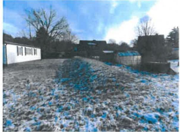
Foto 8: Aufgefüllter Wall südlich der Notunterkünfte, vermutlich Bodenabtrag aus dem Bereich der Unterkünfte
