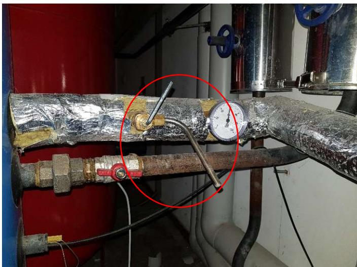
In der Regelung ist eine Warmwasserdesinfektionstemperatur von 65°C einprogrammiert. Die Warmwassertemperatur ist auf 60°C eingestellt. Das Display der Regelung ist teilweise nicht mehr zu erkennen.
