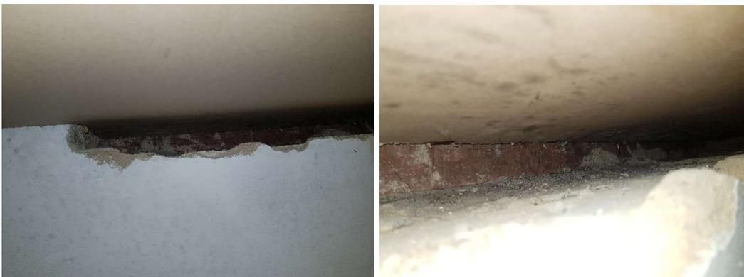
3. In der Wohnung 17 (Zietlow und Krüger) bildet sich unter der Treppe an der Wand zur Eingangstür immer wieder Schimmel. Die Feuchtigkeitswerte betragen bei Messung 60-80 Digits und sind als leicht feucht bis feucht zu bewerten. Im Bodenbereich waren die Werte höher.
