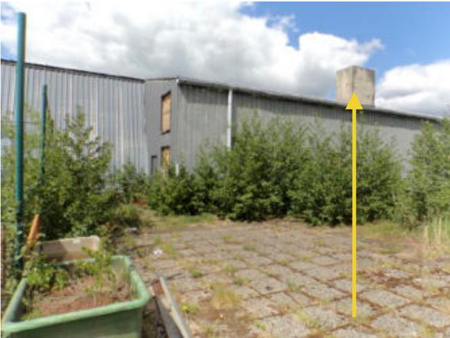
Foto 7: Blick nach Westen auf den Nebeneingang der Tennishalle und den mit vermutl. asbesthaltigen Platten verkleideten Schornstein.
