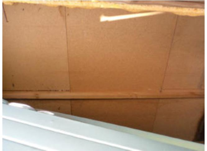
Foto 14: OSB-Platten hinter Blechverkleidung Tennishalle.
