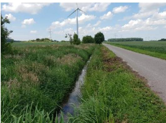
Die Gräben weisen ein Regelprofil mit mehr oder weniger steilen Böschungen auf.
