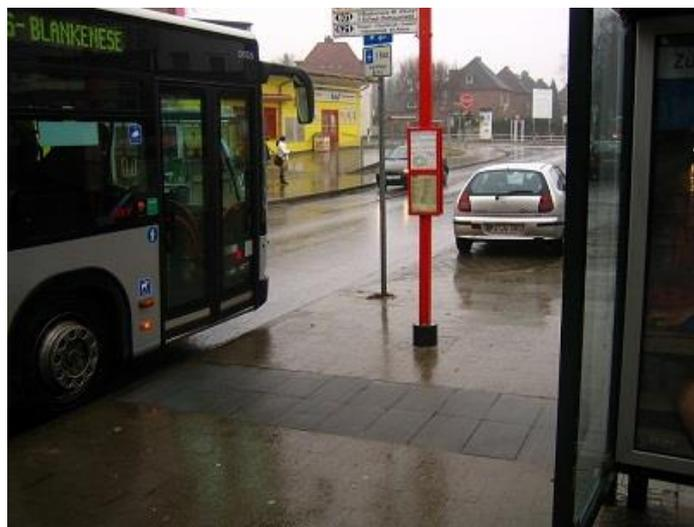
**Bild 28: Haltestellenkennzeichnung mit Hartgummiplatten in Wedel**
