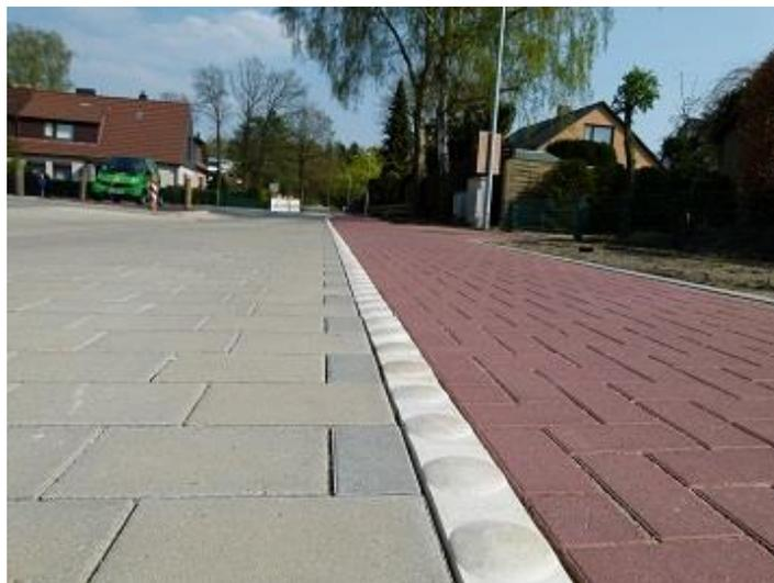
**Bild 38: Großaufnahme des Trennstreifens zwischen Gehbahn und Fahrbahn**
