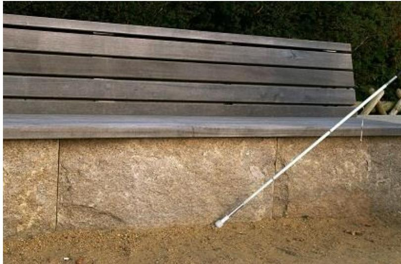
**Bild 14: Bank aus Granitblock mit Holzauflage**
