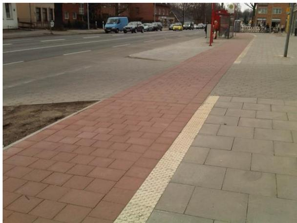
**Bild 33: Geh- und Radwegtrennung an Haltestelle in Hamburg-Lurup (Eckhoffplatz)**
