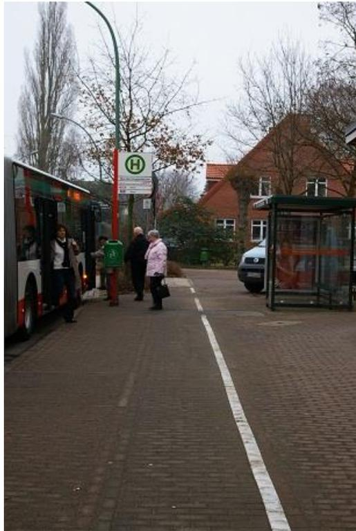
**Bild 30: Geh- und Radweg-Trennung an einer Bushaltestelle in Wedel**
