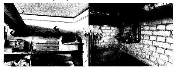
Die Rohrleitungen im Kriechkeller sind sichtbar unter der Decke verlegt. Die Kaltwasserleitungen sind nicht gedämmt und wahrscheinlich noch im Ursprungszustand von 1971.
