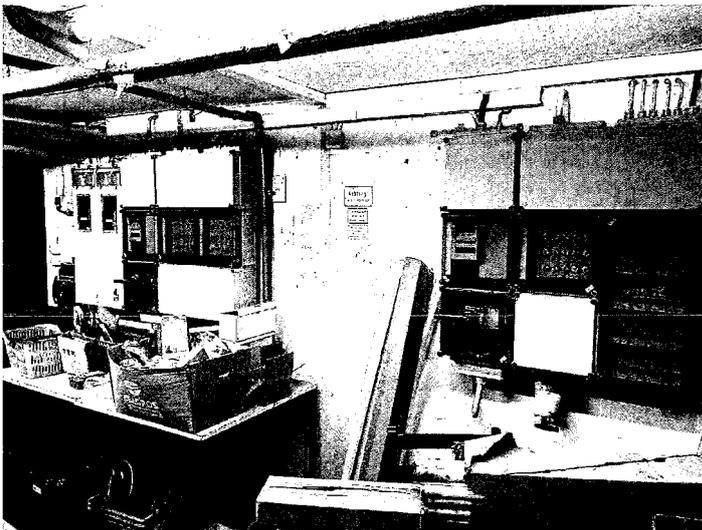
Von den Hauptverteilungen erfolgt der Verzug der Leitungen teilweise im Kriechkeller sowie über den Dachboden. Die Befestigung der Leitungen im Kriechkeller erfolgt über Sammelhalter.
