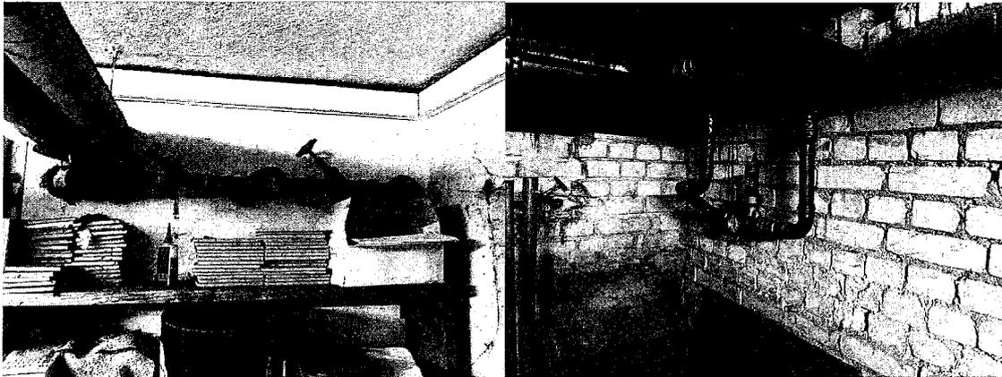
Die Rohrleitungen im Kriechkeller sind sichtbar unter der Decke verlegt. Die Kaltwasserleitungen sind nicht gedämmt und wahrscheinlich noch im Ursprungszustand von 1971.
