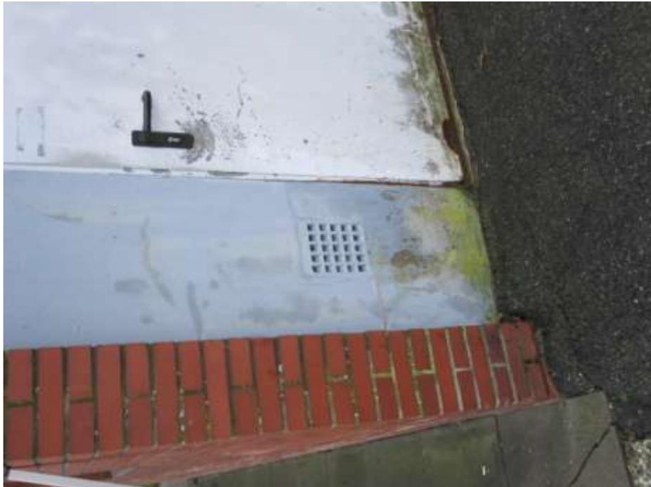
Abbildung 8: Abstellerraum Korrosion an der Tür
