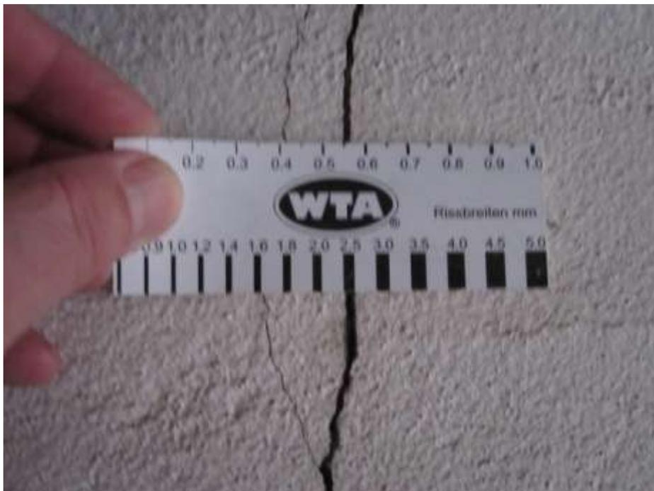
Abbildung 4: Vertikaler Wandriss  $d=2,5\text{mm}$
