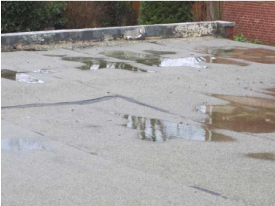
**Abbildung 3: Durchbiegung der Dachoberseite**
