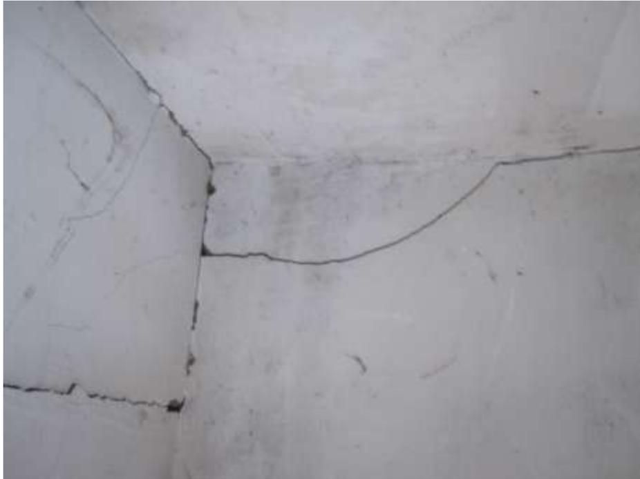
Abbildung 7: Rissbildung am Decken-Wand-Anschluss
